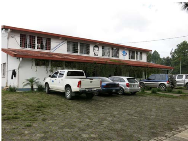
Edificio Oficinas sede central FTK en San Pedro Carchá
